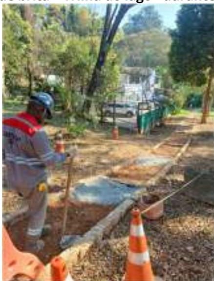
**Figura 115: Recuperação de paralelepípedos, nivelamento, aplicação de brita - Trilha do lago - depois**
