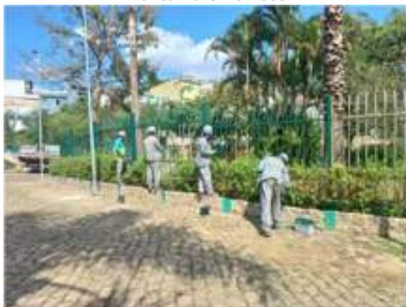
**Figura 87: Pintura de manutenção do gradil, priorizando as entradas do parque - Portaria 3 - depois**
