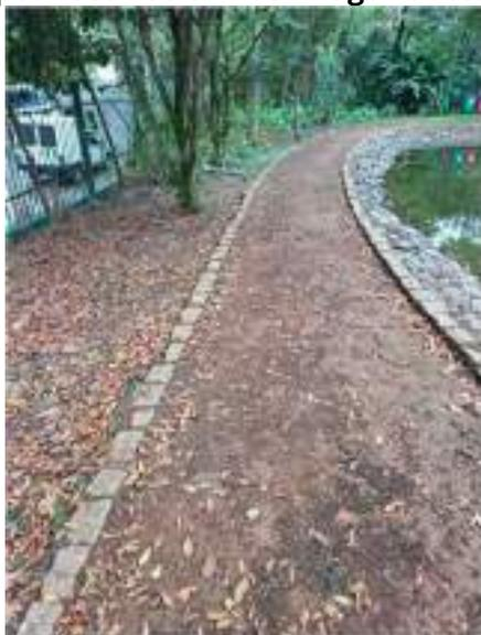
**Figura 117: Nivelamento e aplicação de pedrisco nas trilhas - Lago - depois**
