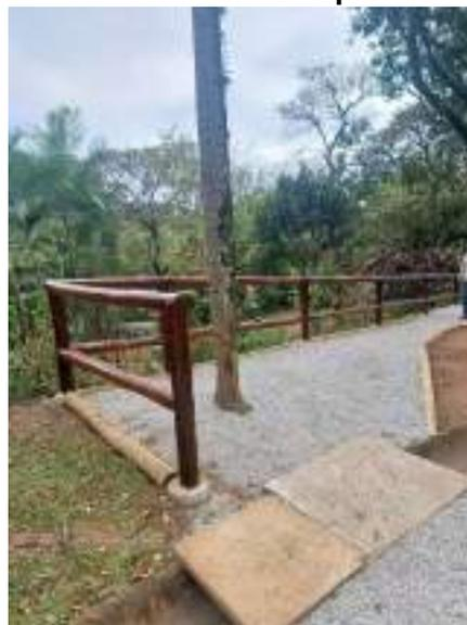
**Figura 106: Instalação de guarda-corpo, delimitação de trilhas com eucaliptos e aplicação de pedrisco - Bocha-churrascaria - depois**
