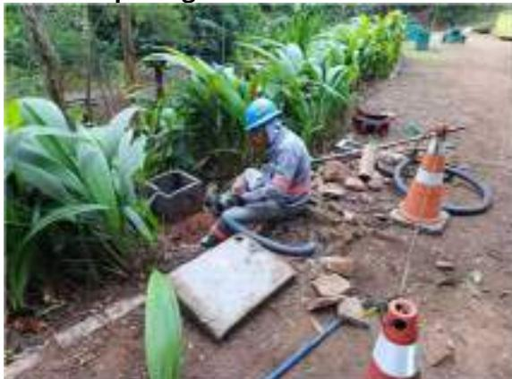
**Figura 65: Readequação de caixa elétrica fora da passagem - Churrascaria - depois**
