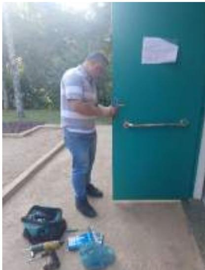
**Figura 97: Troca e manutenção de fechaduras – Copa**
